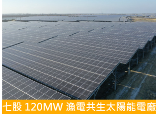
七股 120MW 漁電共生太陽能電廠
