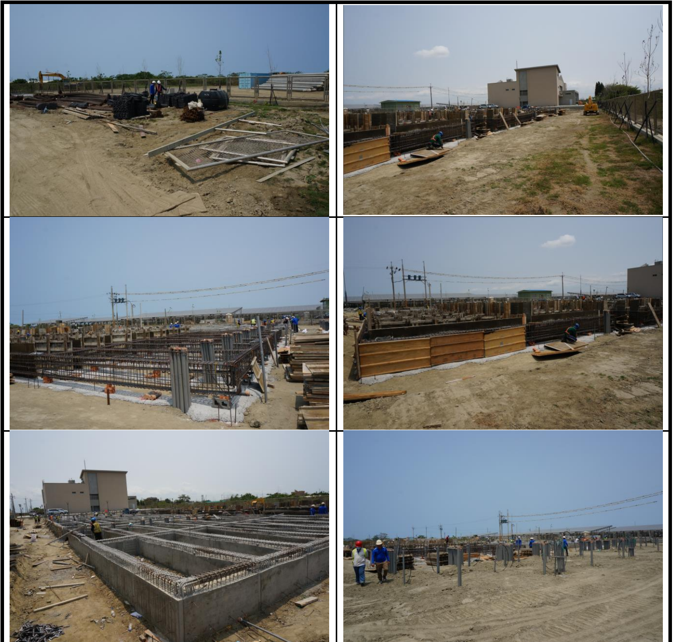
■ 施工區外道路平整，並定時安排灑水車抑制揚塵。
