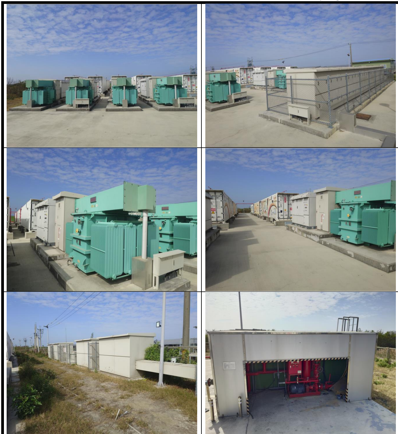
場區外圍道路平整
